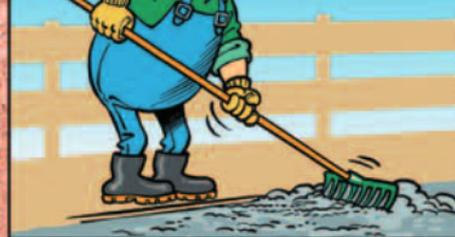
FALLS ES NOTWENDIG IST, DEN BETON ZU VERTEILEN, SIND SCHAUFEL ODER RECHEN ZU BENÜTZEN UND NICHT DIE VERDICHTUNGSGERÄTE WIE Z. B. RÜTTELFLASCHEN.
