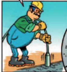
SOFORTIGES VERDICHTEN NACH DEM EINBRINGEN DES BETONS.
